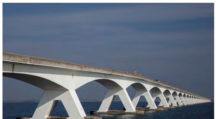
▲ De Zeelandbrug en zijn constructie (Beeldrechten: Provincie Zeeland)
